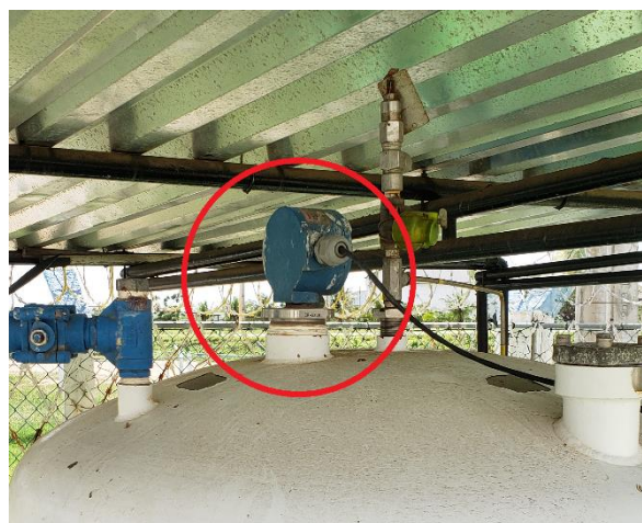
Figura 6 - Bocal de conexão 2" NPT
